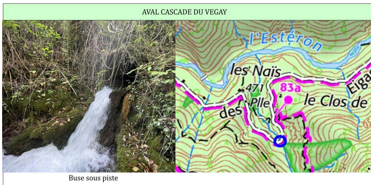
Illustration 48 : Site potentiel pour l'installation d'une station de jaugeage en aval de la cascade du Végay
