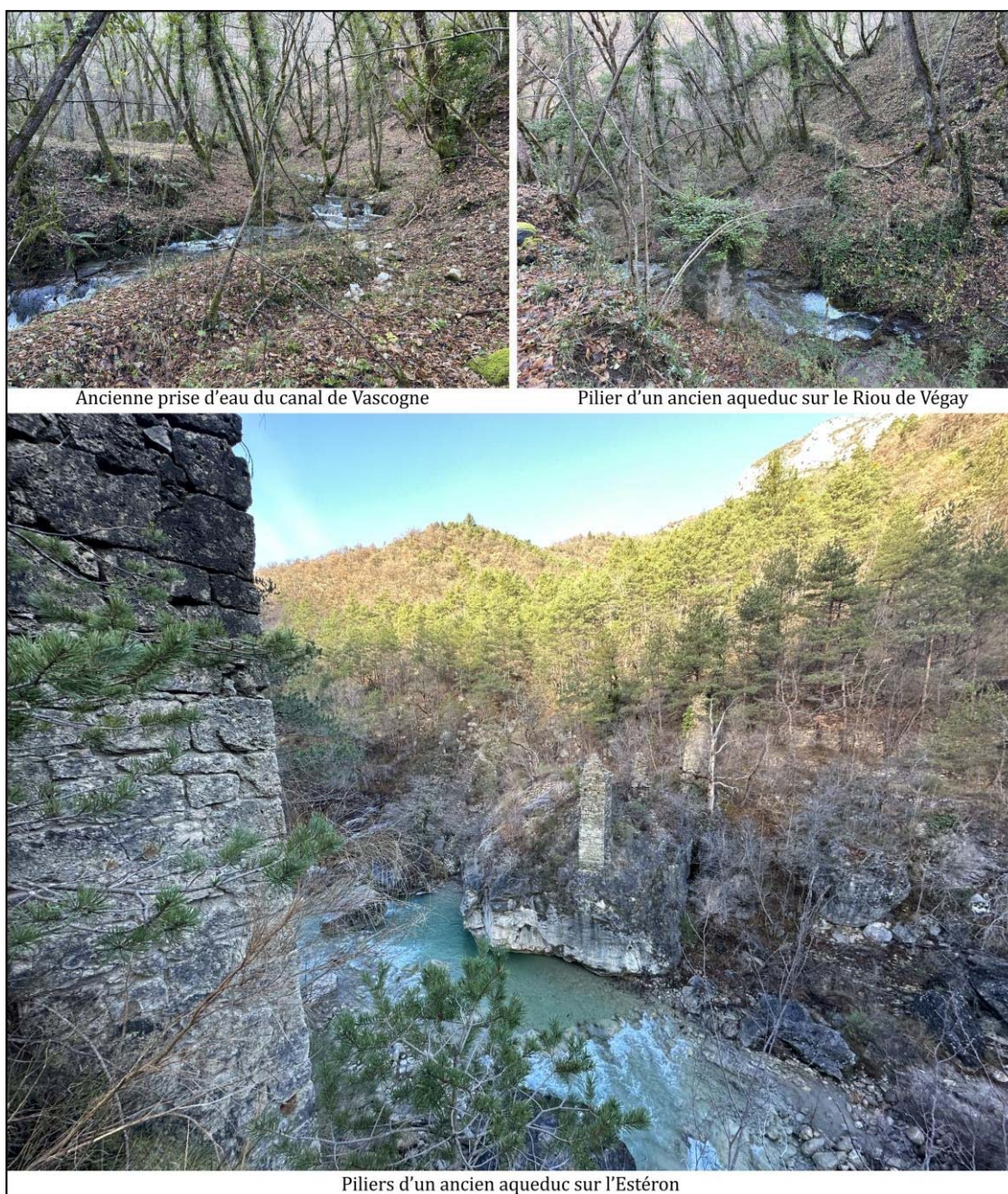
Illustration 30 : Traces de l'ancienne prise d'eau et aqueducs du canal de Vascogne de 1873
